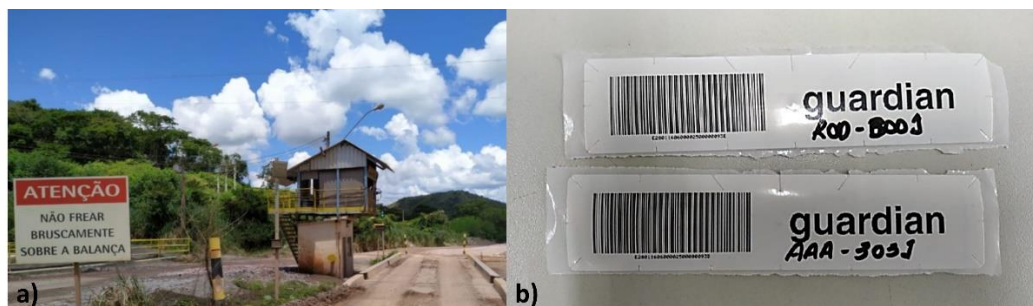
Figura 3 - a) Balança localizada na saída de uma das rampas da mina subterrânea, b) Transponder utilizado na comunicação entre os caminhões e as balanças
